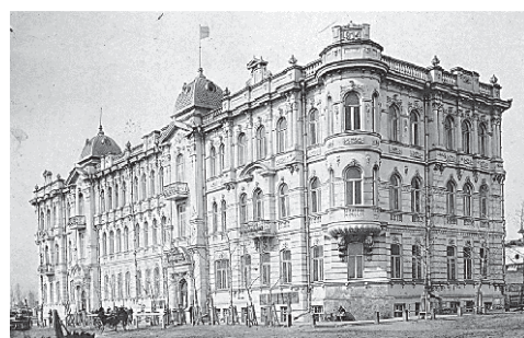
Дом правительства ДВР (дом братьев Шумовых) постановлением Дальревкома № 413 от 27 июня 1923 года передан Забайкальскому губернскому Совету профсоюзов. До 1937 года дом называли «Дворец труда», «Дом союзов». Здесь же размещался профсоюзный клуб имени А.В. Луначарского, библиотека, читальня, Красный уголок. Фото 1923 г. из фондов Забайкальского краевого краеведческого музея
